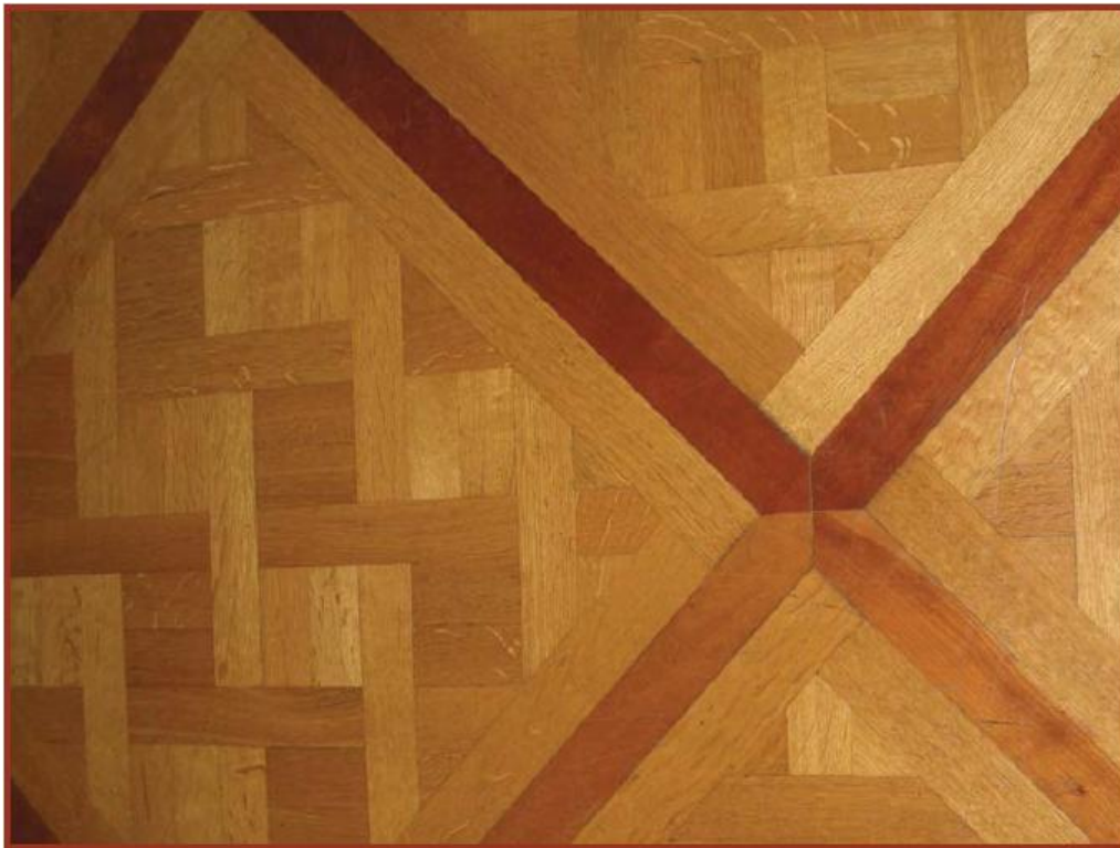
Particolare del pavimento in parquet con legno di rovere e inserti di ciliegio. Detail of the parquet floor in oak, with cherry inserts.
