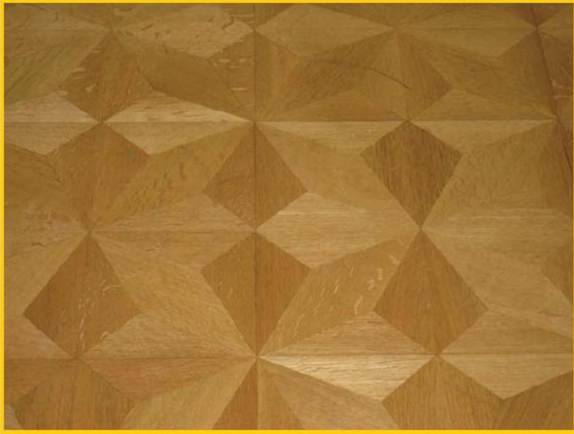
Dettagli dei parquet in legno di rovere e ciliegio delle camere. Details of the bedroom floors in oak and cherry parquet.
